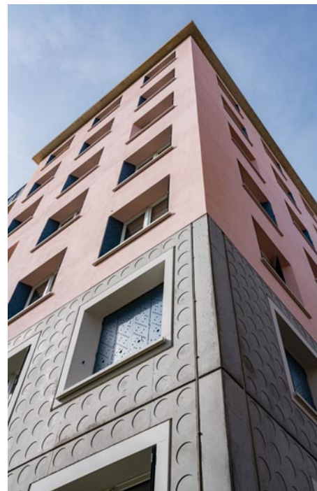
Obwohl das Relief eine Tiefe von nur 5 Millimeter hat, erzeugt es ein schönes Schattenspiel auf der Fassade
